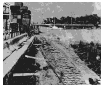
图 4 昆仑饭店基槽坡顶加载试验全景
