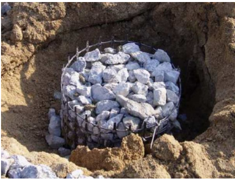
图 1 筋箍碎石桩工程图片
