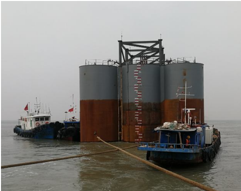
图 2 多隔舱钢桶基础结构现场安装
