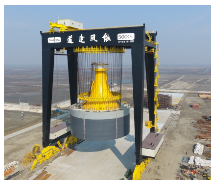
图 2 复合桶型基础现场结构图
