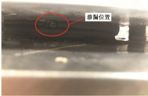
图 9 “T 字缝”角部渗漏
