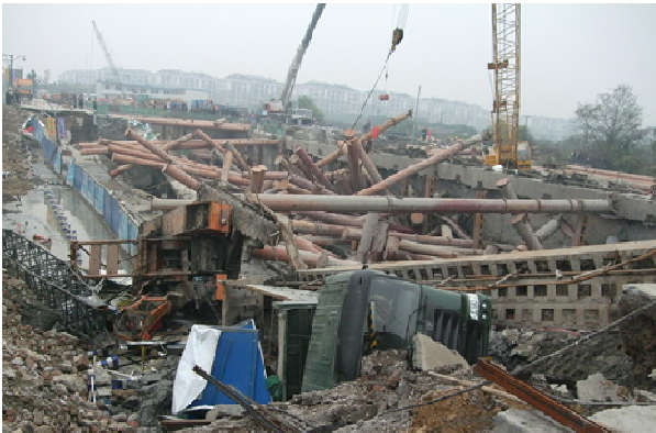
图 4 湘湖基坑倒塌现场 [15]
