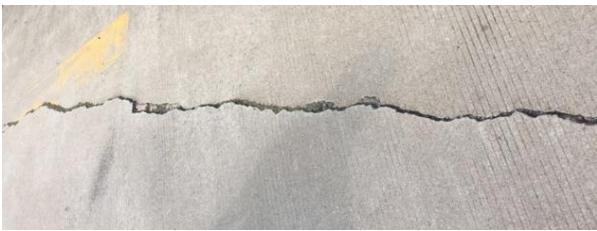
图 19 隧道中部段地表开裂
