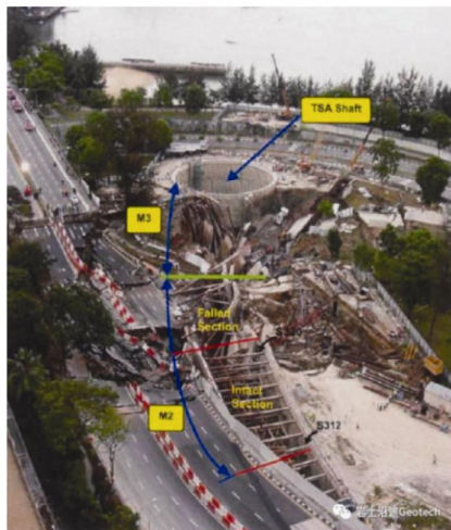
图 13 Nicoll highway 基坑倒塌现场 [4]
