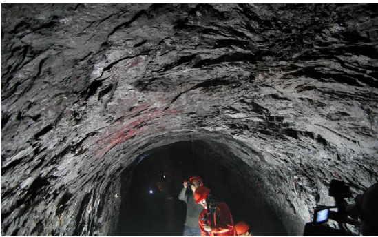
图 3 地下洞室围岩片帮破坏特征
