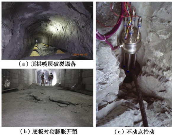
图 12 锚固洞围岩时效变形与破坏现象
