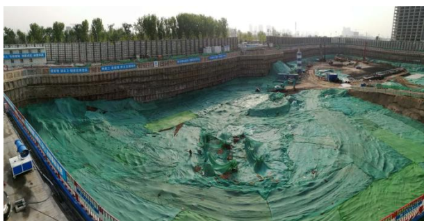
图 1 基坑支护现状图
