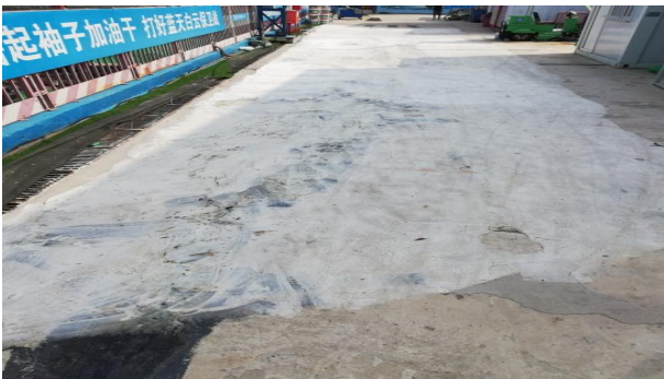
图 2 现场裂缝处理图
