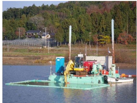
图3 挖机改装的疏浚设备 [10]
