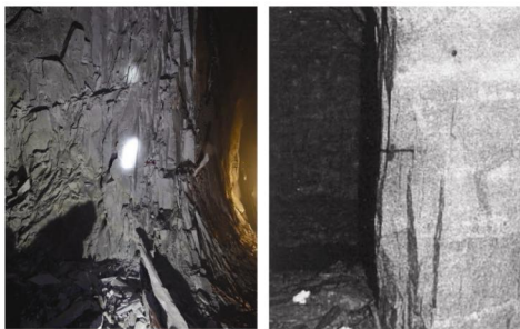
图 1 隧洞边墙板裂破坏现象 [8-9]
