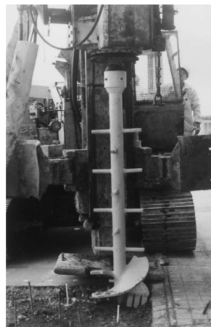
图 1 West Drayton 项目中使用的单螺旋钻 [15] Fig. 1 Auger used in West Drayton field trials [15]
