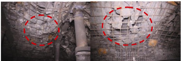
图 11 顶板破碎
