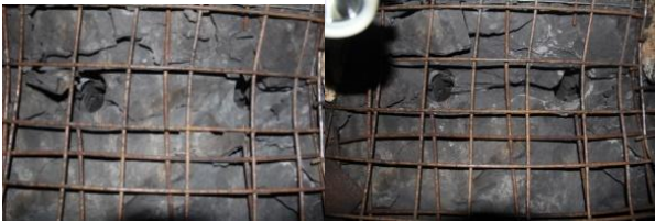
图 15 双向聚能爆破后孔口裂缝效果
