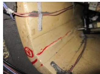
(c) 第 3 条裂缝 (左墙脚)
