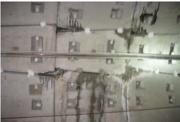
(b) 拱顶部管片结构棱角破损
