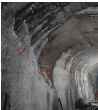
图 3 廊道裂缝情况
