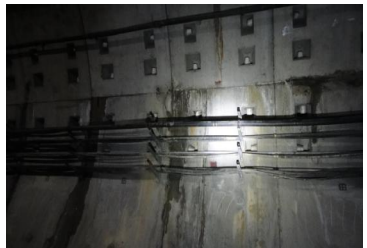
(c) 侧部发生结构渗漏水
