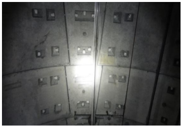
(a) 拱顶部纵缝接头张开螺栓外露
