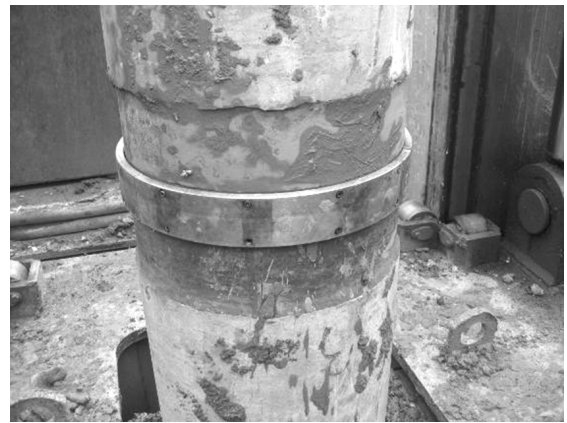
图 3 抗拔管桩采用抱箍式连接的现场照片
