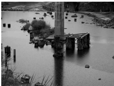
图 11 筐网基桩群保护后桥墩附近河床淤积
