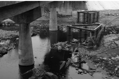
图 7 大埔桥上游布置筐网基桩群
