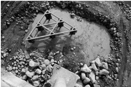
图 10 义仁桥筐网基桩群保护
