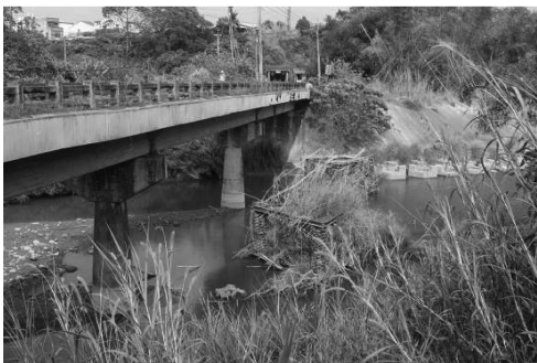
图 9 大埔桥受到保护后桥墩附近淤积
