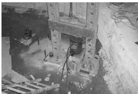
图3 锚杆静压桩施工
