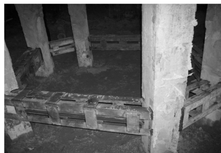
图5 锚杆静压桩屈曲变形控制
