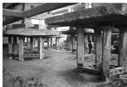
图4 原有基础下部土方开挖
