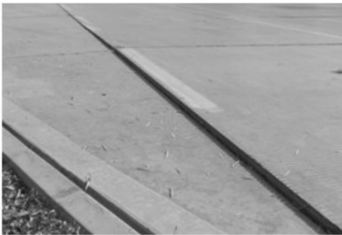
图 6 路面整体抬升 Fig. 6 Uplifted pavement
