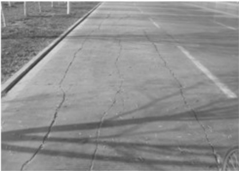
图 7 纵向平行裂缝 Fig. 7 Parallel longitudinal cracks
