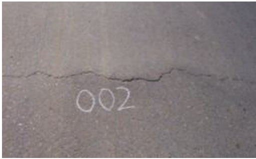
图 4 横向裂缝伴随一定凸起
