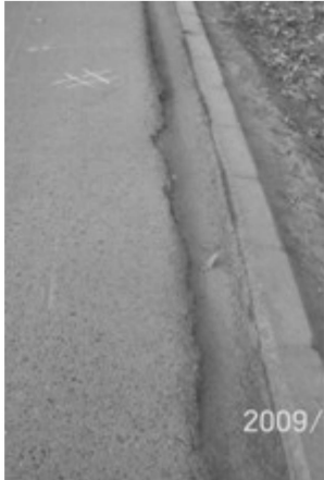
图 9 边缘凹陷 Fig. 9 Recessed edge
