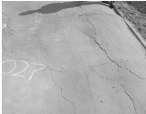
图 5 路面鼓胀并伴有大量裂缝
