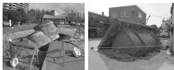
(a) 浮出地面的下水管道窖井 [10] (b) 液化上浮的空燃油罐 [15]
