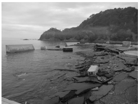
图 11 岩手县一码头流滑破坏失稳 [22]
