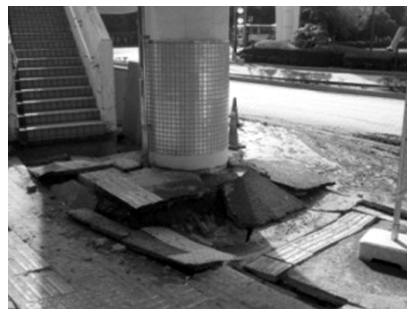
图 6 高架公路基础周边的破坏
