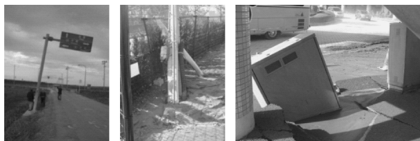
(a) 倾斜的路标 (b) 倾倒的电线杆 (c) 舞滨车站附近不均匀沉降的变压器 [14]
