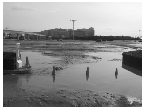
图 3 大面积液化的迪斯尼乐园停车场 Fig. 3 Widespread liquefaction in parking area of Disneyland
