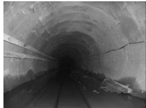
图 6 锚注支护巷道维护状况
