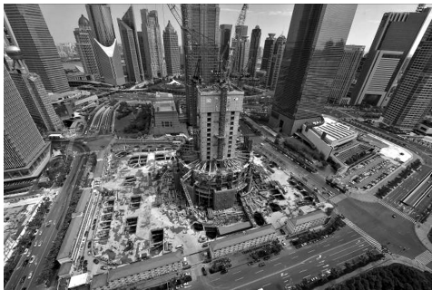
图 15 上海中心基坑逆作施工现场照片
