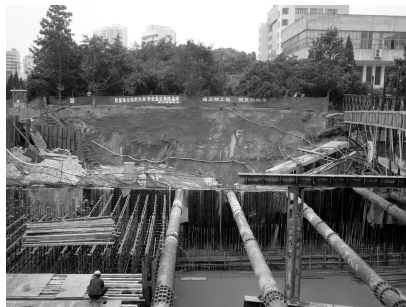
图 3 基坑坍塌处理实施效果
