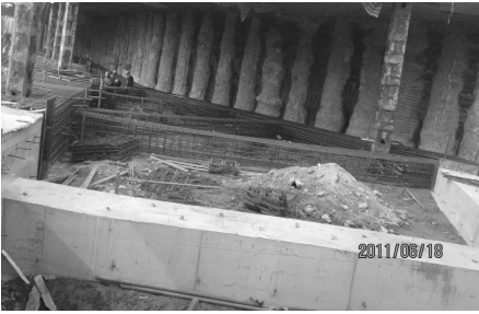
图 14 基坑侧壁实景照片
