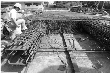
图 3 带支腿地下连续墙绑扎现场 Fig. 3 The binding site of the outrigger-type diaphragm wall
