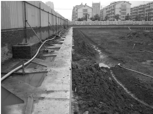
图 10 桩顶 W 型拉梁
