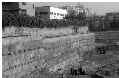
图 7 被动区注浆加固施工
