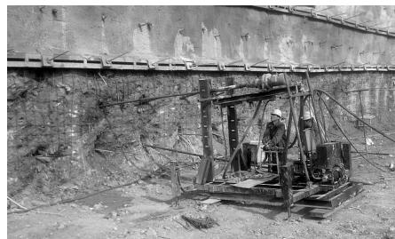
图 6 主动区注浆加固施工
