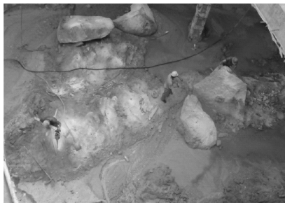
图 6 坑内孤石爆破实拍图
