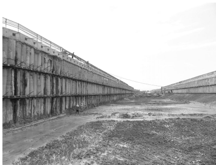
图 15 基坑开挖到底的照片
