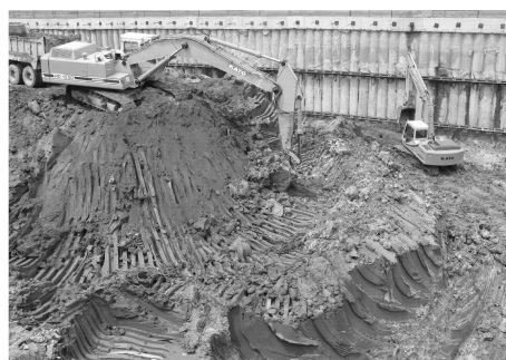
图 3 基坑开挖过程中,固结后的淤泥
