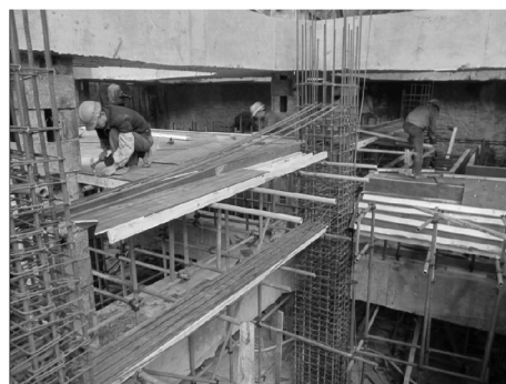
图 6 支撑后拆现场结构施工照片
