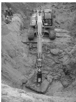
图 5 现场清障图 Fig. 5 Removing underground abstacle
