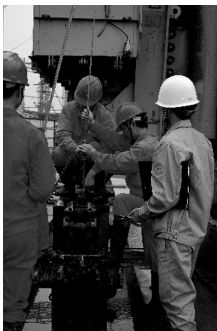
图 4 安装测斜仪 Fig. 4 Installing inclinometer
