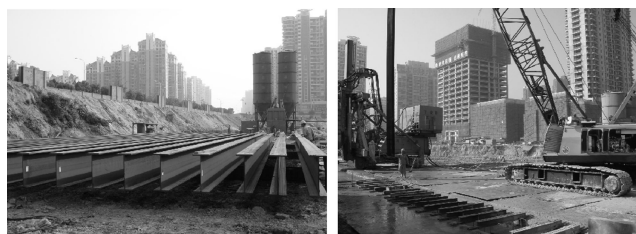
图 9 H 型钢加工及插入图
