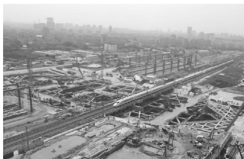
图1 改建铁路宁波站与换乘地铁基坑一体化开挖施工现场
