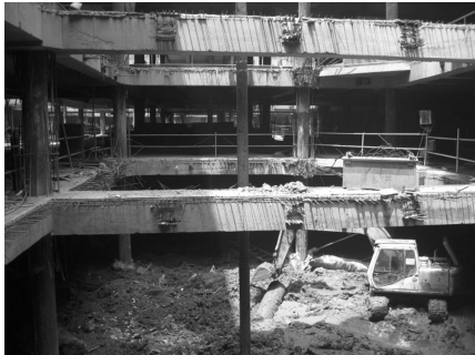
图 11 基坑逆作开挖现场照片
