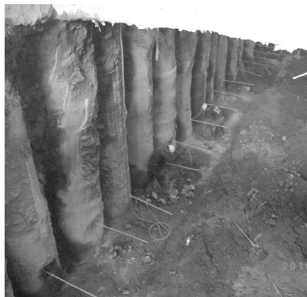
图 5 基坑开挖后暴露的围护桩
