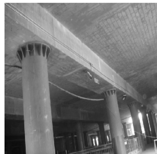
图 16 钢管柱作结构柱
