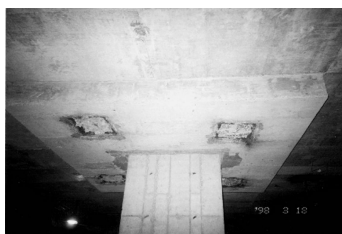
图 15 钢立柱割除后的结构柱
