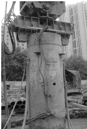
图 7 预制方桩拔桩设备
