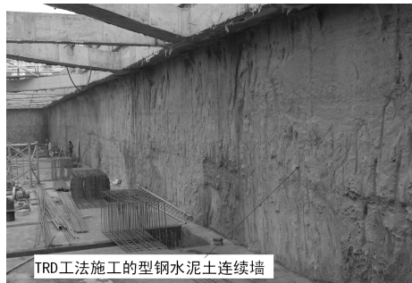
图 5 某基坑开挖后的 TRD 工法型钢水泥土连续墙
