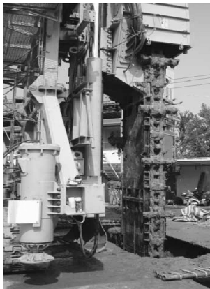
图 3 TRD 工法设备
