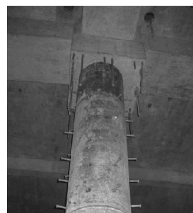
图 17 钢管外包混凝土作结构柱
