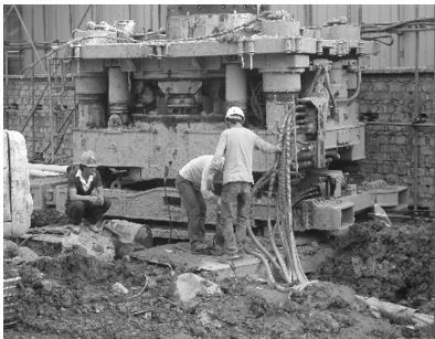
图 9 \Phi 900 mm 钻孔桩拔桩设备
