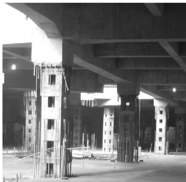
图 18 钢立柱外包混凝土作永久结构柱
