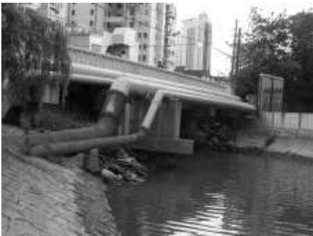
图 4 桥下管线布置状况
