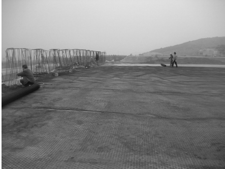
图 5 路堤加筋现场
