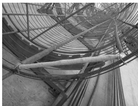
图 1 U 型压浆管道布置图
