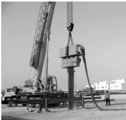
图 1 高频液压振动锤沉桩 (板桩)
