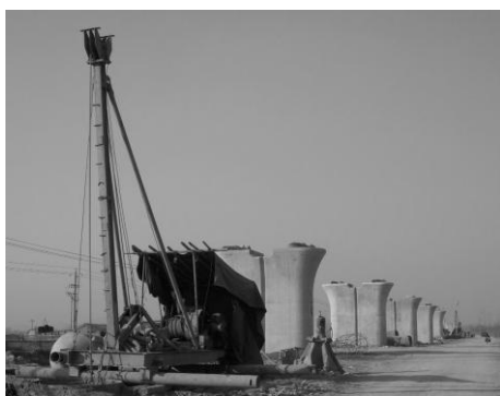
图 2 高铁桥墩施工
