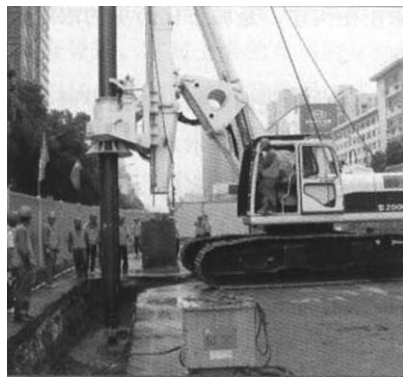
图 18 旋挖桩施工
