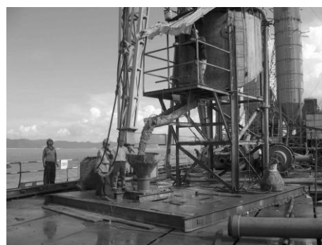
(b) 钻孔桩施工
