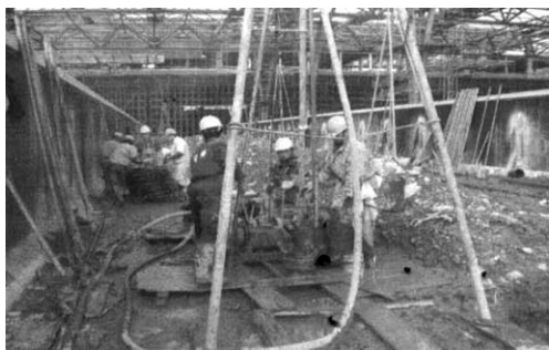
图 25 地源热泵系统施工现场
