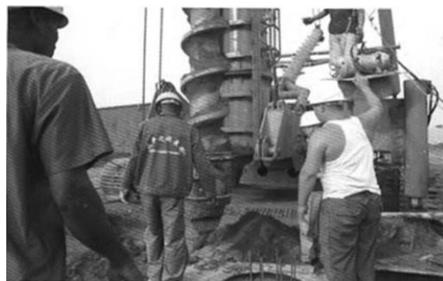
图 19 长螺杆桩施工
