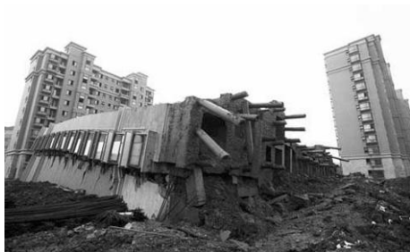
(b) 基桩被拔出
