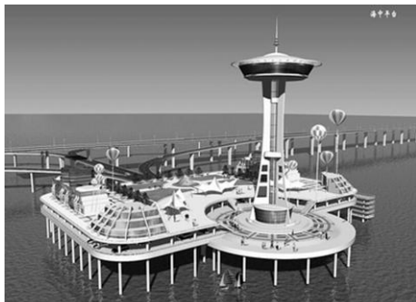
(b) 桥旁支承于桩基的海上观景平台, 面积达1万 \text{m}^2 , 并可供船舶停靠、加油补给及海上救援之用
