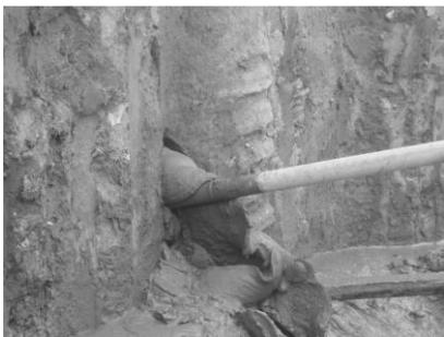
图 6 旋喷搅拌加劲桩成桩对软土的置换过程
