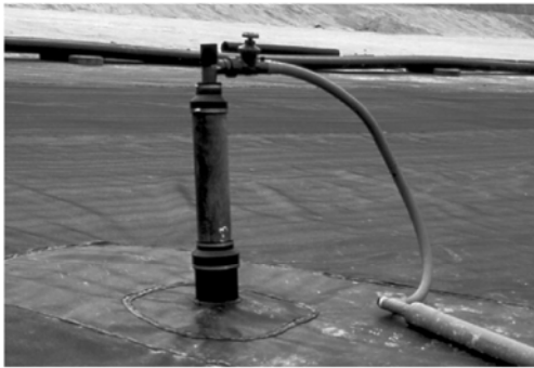
图1 圆形构筑物与土工膜连接图
