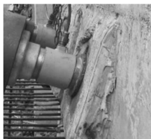
图4 锚索测力计安装照片
