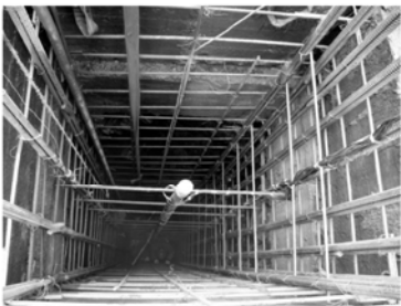
图3 测斜管安装照片
