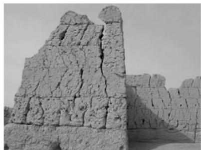
图 11 垛泥墙接槎缝 (东北佛寺西墙入口 10 m 处)
