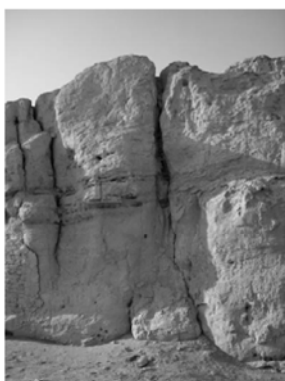
图 1 官署区卸荷裂隙
