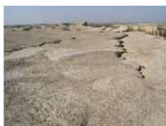
图 16 崖边卸荷裂隙 (台地北部东崖)
