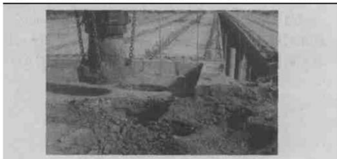
图3 桥台背填土施工现场
