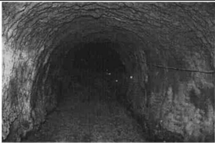
图 3 锚注加固后重新掘开的巷道
