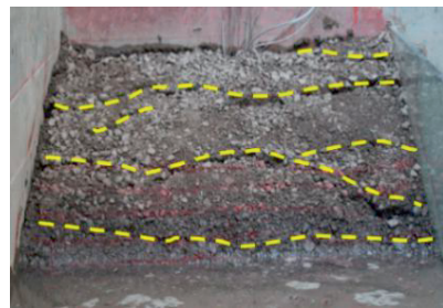
(a) 第一次最高库水位时坡体后缘裂缝
