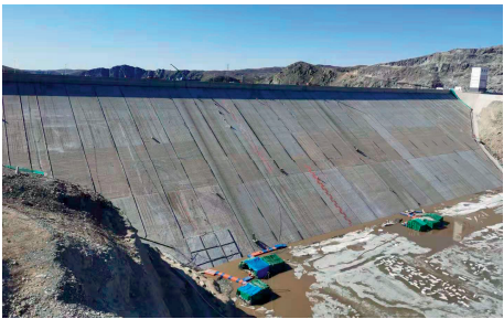
图 21 JL 大坝面板修复面貌 Fig. 21 Repair process of JL CFRD
