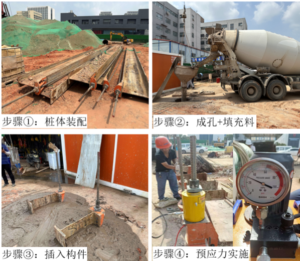
图 9 PMW 的施工工艺
