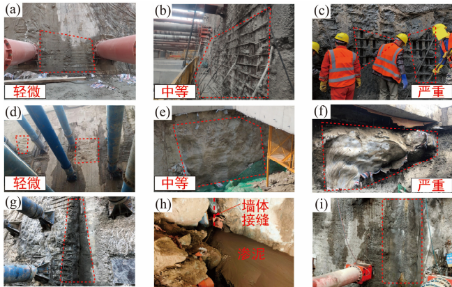
图 11 地连墙墙板缺陷现场照片：(a-c) 墙板露筋；(d-f) 墙面鼓包；(g-i) 接缝破损
