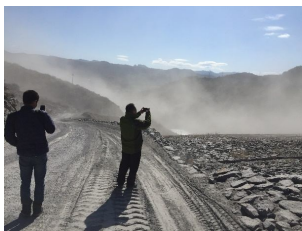
图 1 贮灰场中粉煤灰固化不良造成的粉尘污染
