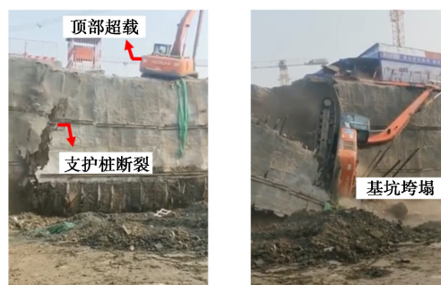
图 2 基坑顶部存在超载问题后垮塌
