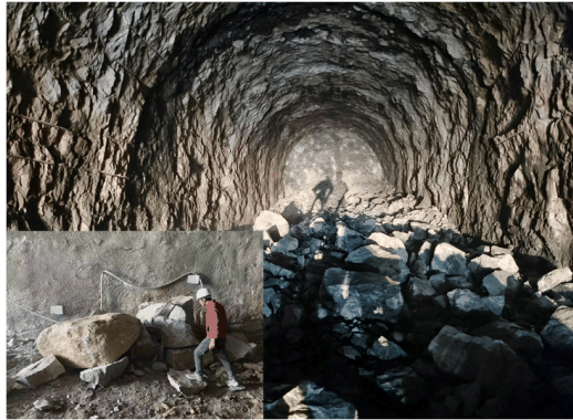
图 1 深埋隧洞开挖爆破后的大块岩石
